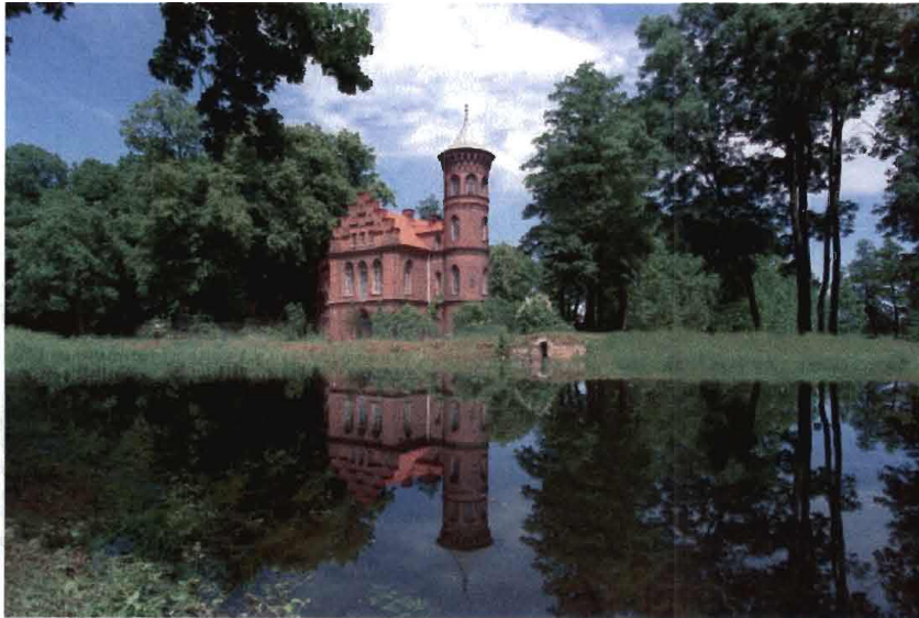
Fot. stan istniejący
