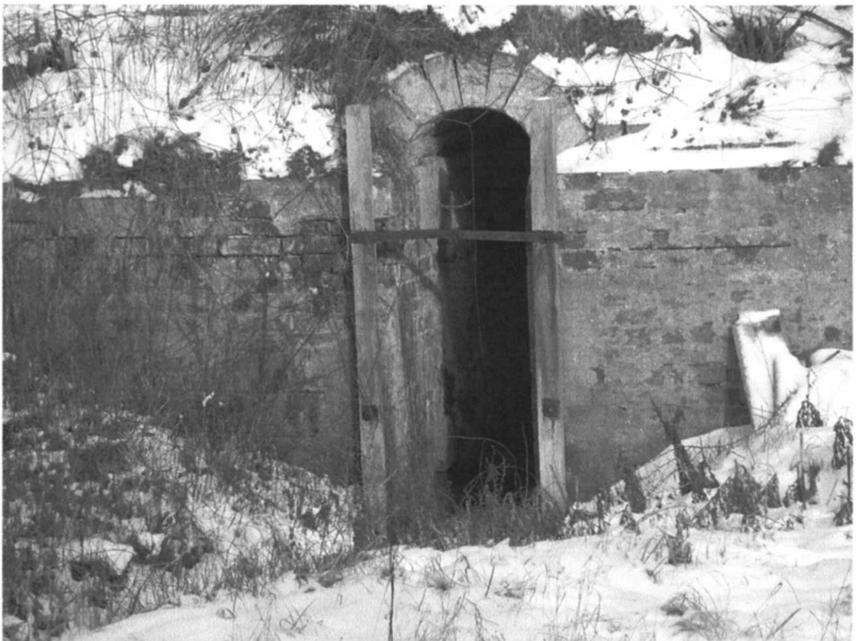
Istniejący przepust z piętrzeniem o wym. 195x40cm na odpływie rowu R-10 ze stawu nr.1 zakwalifikowany do remontu i przedłużenia o 3,5m z zachowaniem istniejącej architektury.
