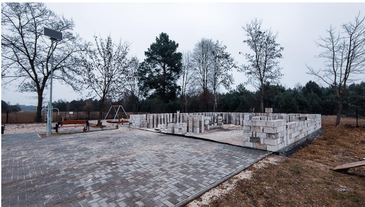
Fot. 15 Budowa garażu dla pojazdów bojowych OSP Lipianki
