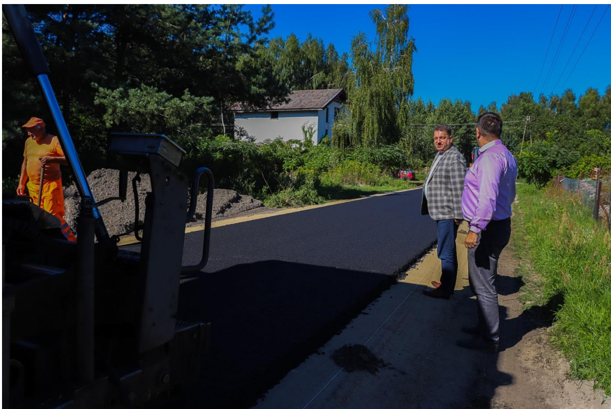
Fot. 9 Przebudowa drogi gminnej w m. Brwilno Dolne
