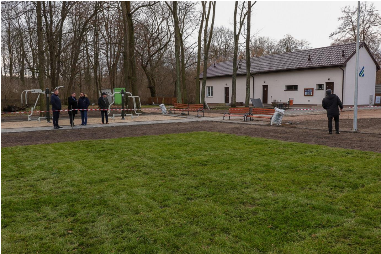
Fot. 22 Modernizacja boiska sportowego LKS w m. Nowy Duninów
