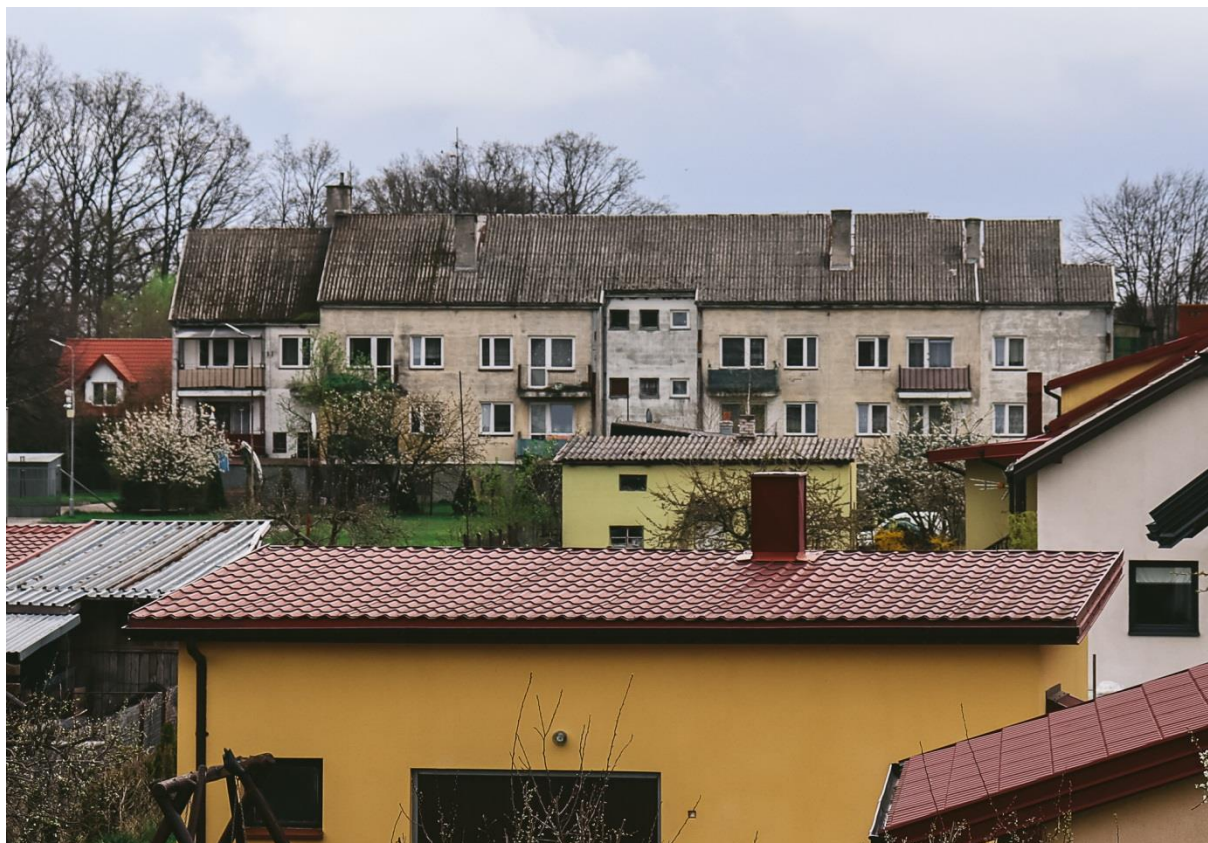
Fot. 12 Wymiana pokrycia dachu w bloku komunalnym przy ul. Słonecznej w Nowym Duninowie
