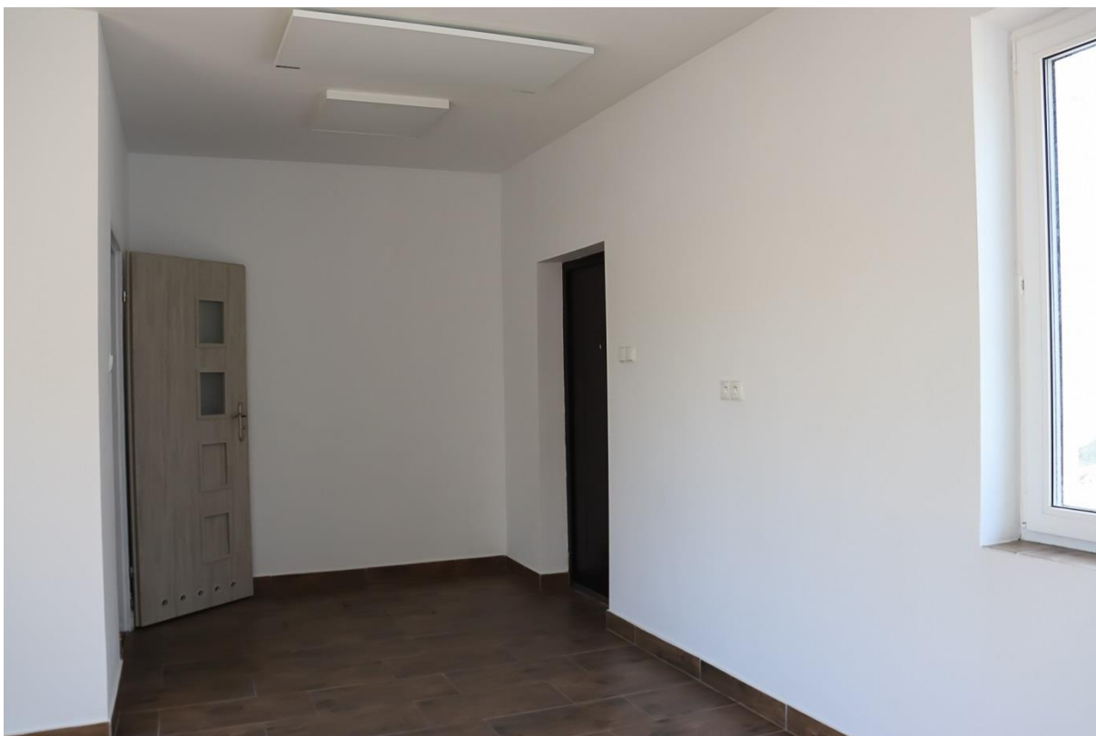
Fot. 21 Modernizacja zaplecza sanitarno-socjalnego przy boisku LKS w m. Nowy Duninów
