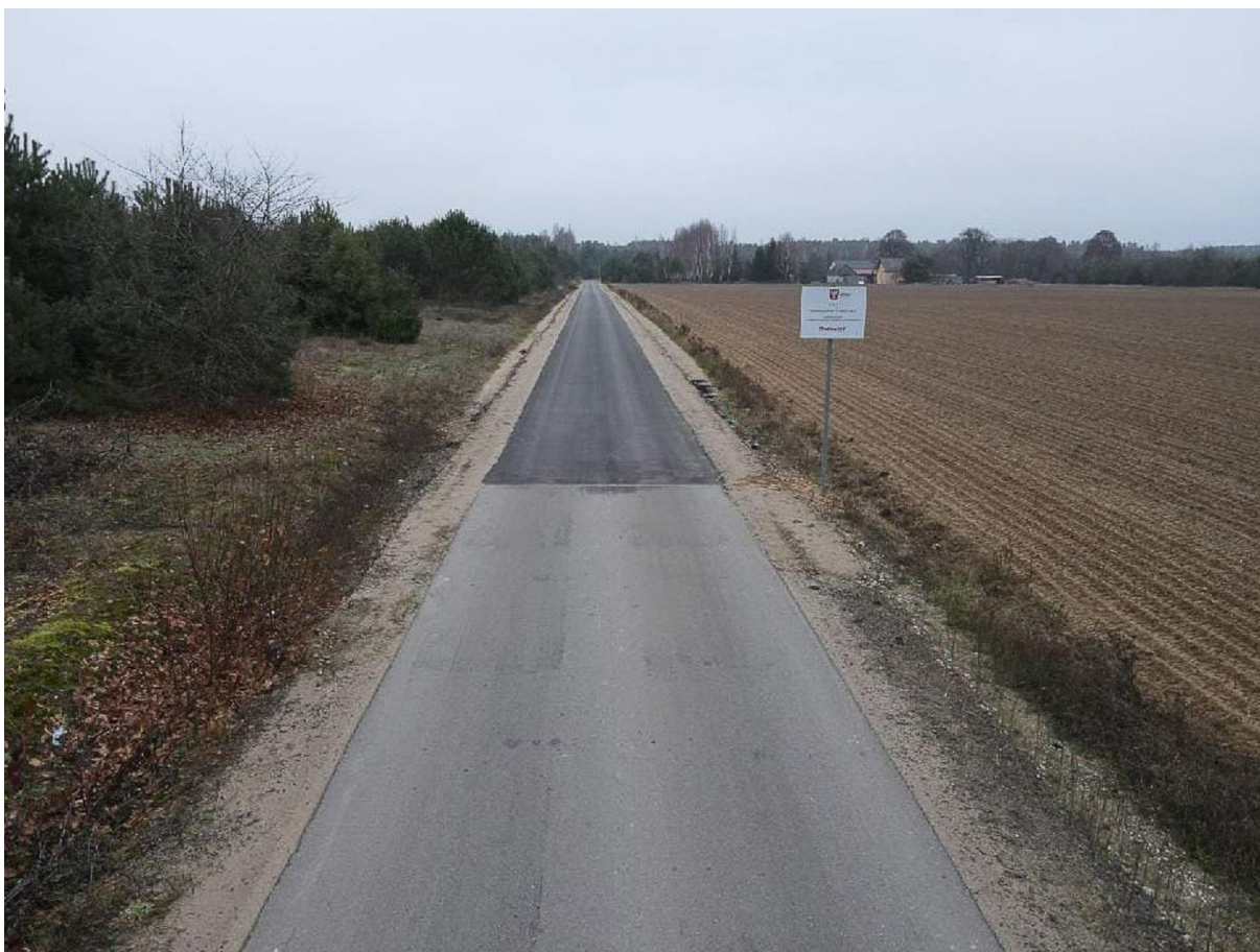
Fot. 11 Przebudowa drogi gminnej w m. Lipianki
