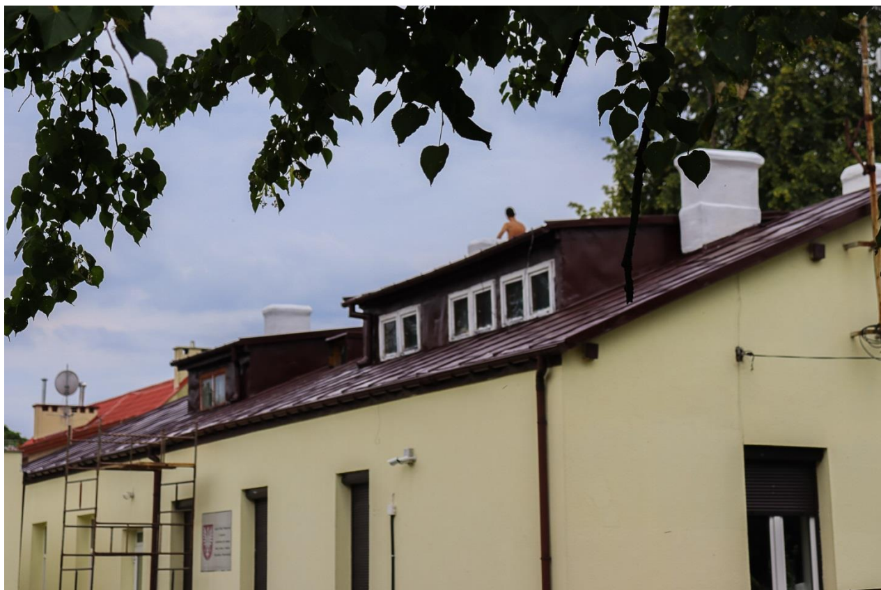
Fot. 31 Malowanie pokrycia dachowego budynku Szkoły Filialnej w Soczewce
