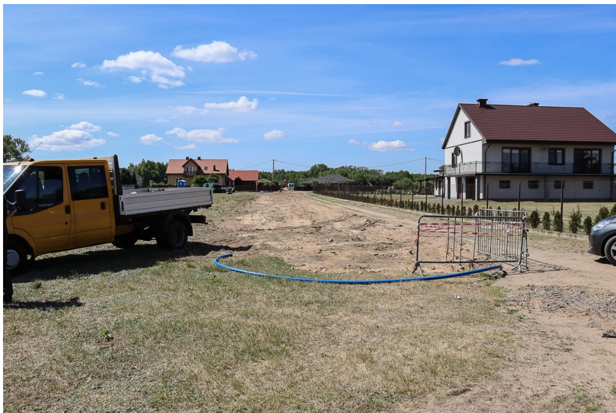
Fot. 6 Budowa kanalizacji w Karolewie - II etap
