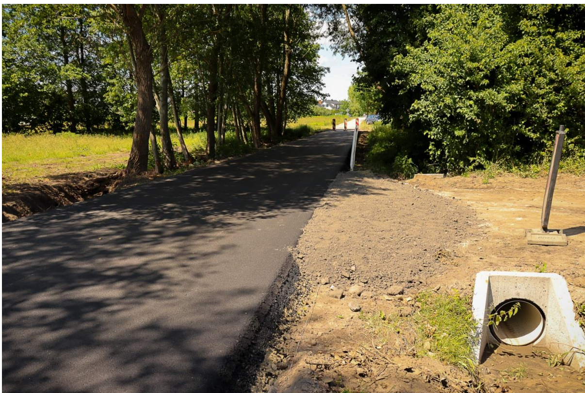
Fot. 8 Przebudowa drogi gminnej Nowy Duninów-Trzcianno
