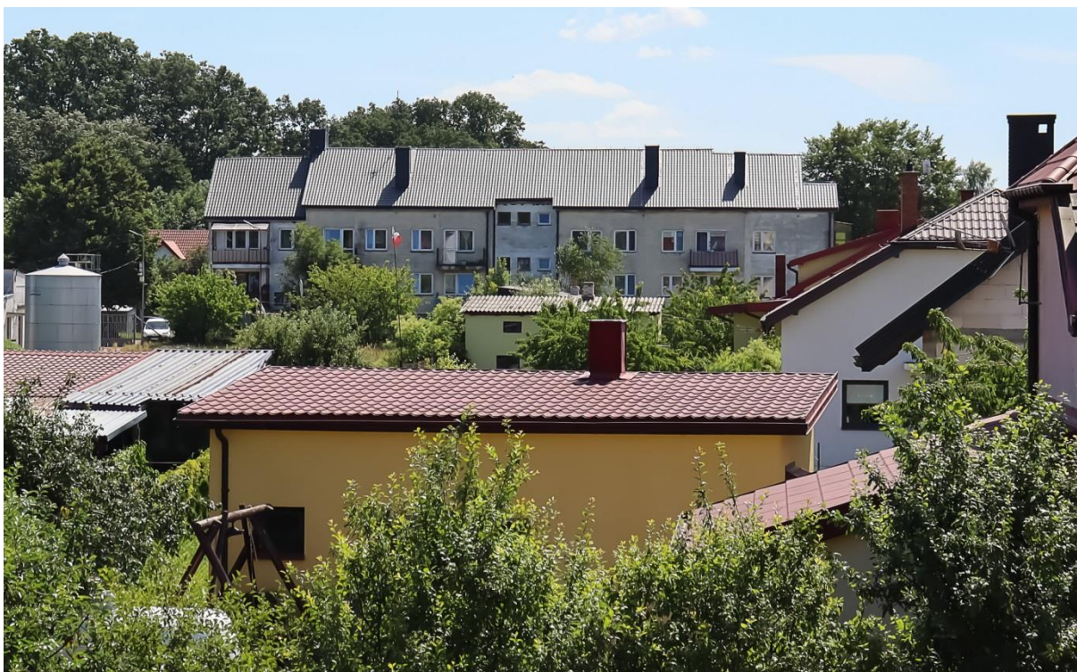
Fot. 13 Wymiana pokrycia dachu w bloku komunalnym przy ul. Słonecznej w Nowym Duninowie
