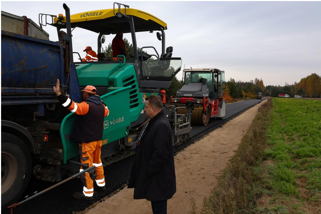
Fot. 10 Budowa drogi gminnej w m. Lipianki Etap II
